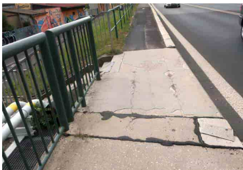
Obr. 2.3 – Typický stav mostního závěru v oblasti chodníku
