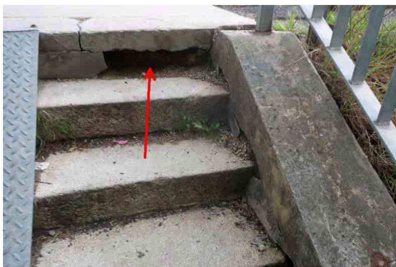
Obr. 2.5 – Rozpad betonu přístupového schodiště
