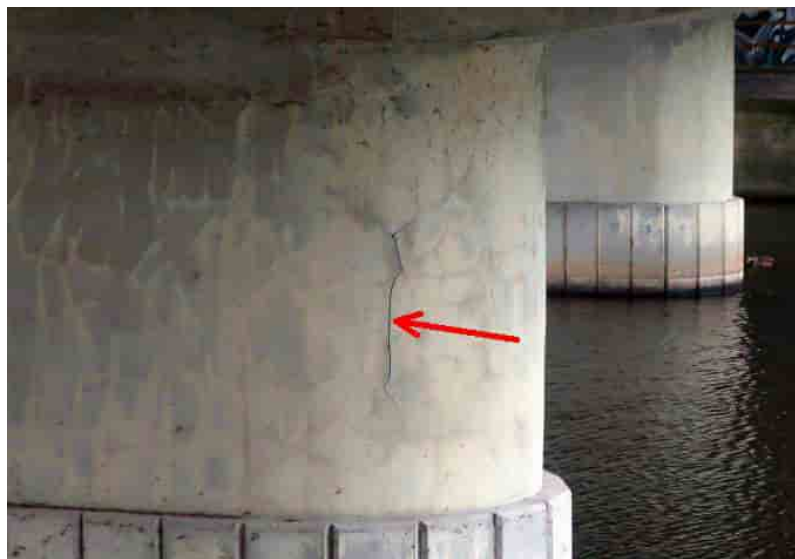
Obr. 2.1 – Separace sanace na líci pilíře
