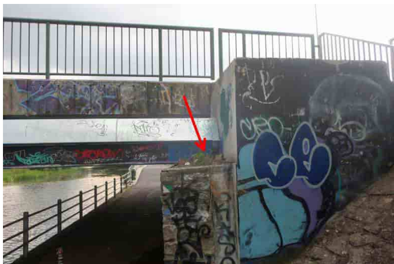
Obr. 2.4 – Nánosy na úložném prahu opěry
