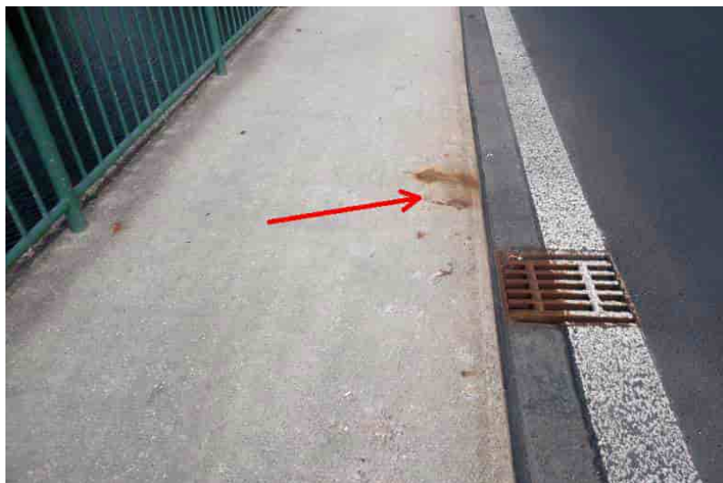
Obr. 2.6 – Degradace betonu a koroze výztuže chodníku
