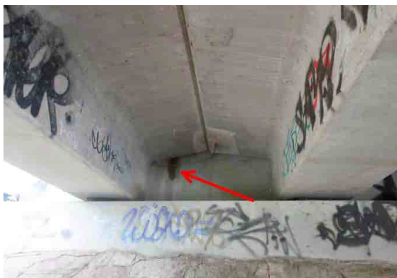
Obr. 2.2 – Průsak dilatační sparou
